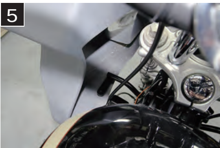
5 カウルをフィッティングする。 ※フィッティング時、画像のようにカウルと固定ステーが合わさる事を確認しておく
